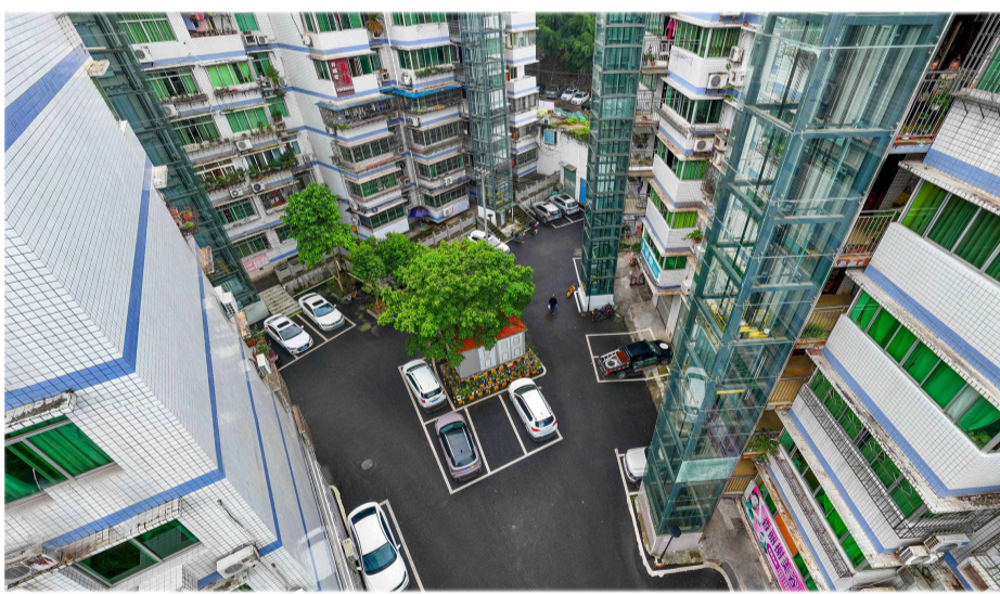
改造后的老旧小区
