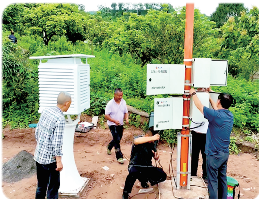
技术人员对气象设备进行安装调试
