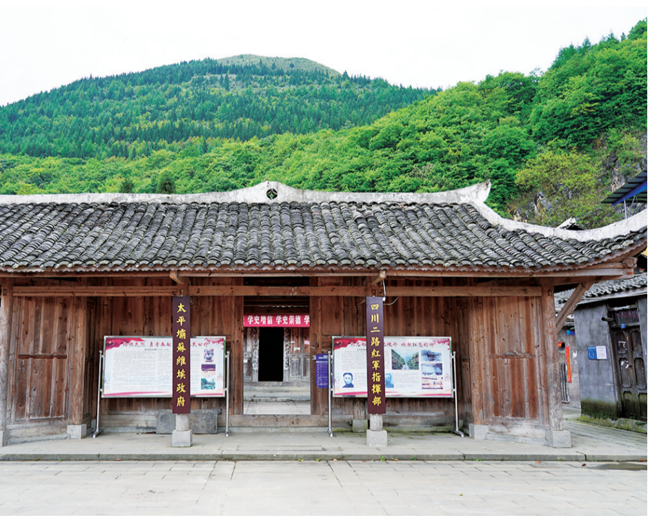
太平坝苏维埃政府旧址
