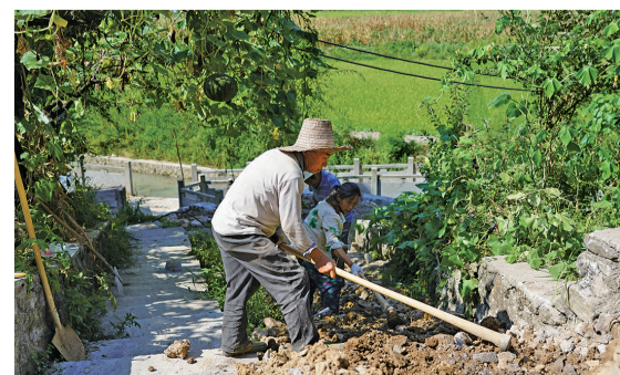
农民工正在修道路
