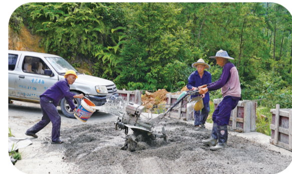
工人搅拌混凝土
